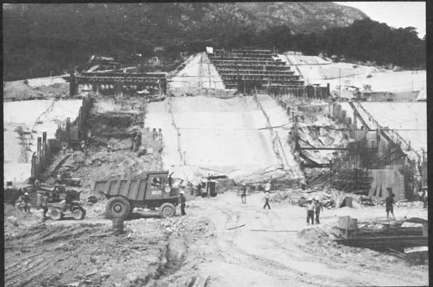
正在施工發掘中之黃竹坑隧道口
